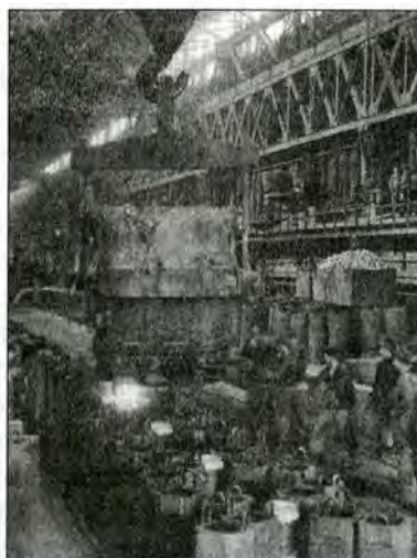
Сталелитейный цех завода Круппа. 1900 г.
